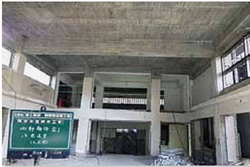
本堂内部の解体（内陣側より）
