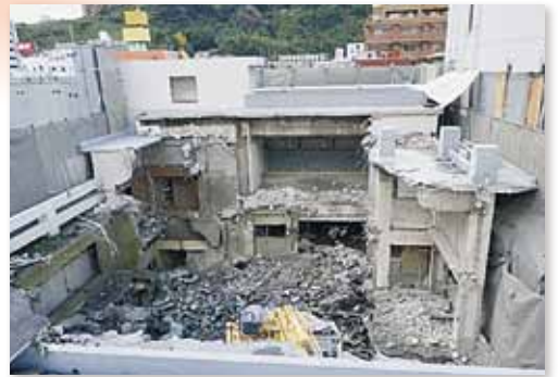
本堂の解体（東側より）
