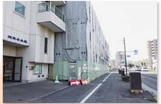
解体作業の足場（城西本通り側）
