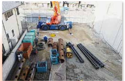
杭板工事（東側より）
