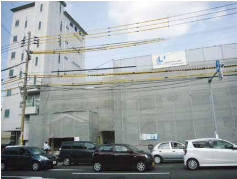
五月に本堂等の壁面修理、塗装をおこないました。
